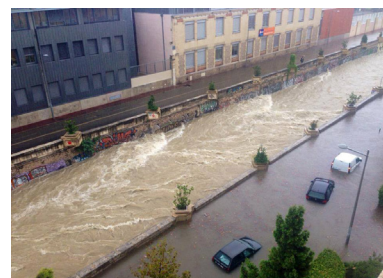
Quai du Verdanson
