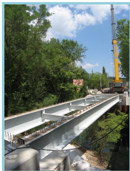
Doublement du pont de la RD 145 Prades -le-Lez
