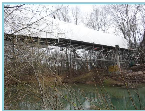
Restauration de canalisations aériennes Monferrier-sur-Lez
