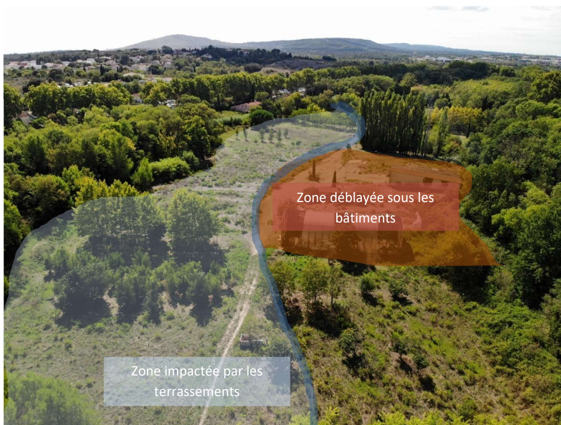
Figure 8 : Représentations schématiques de la limite des emprises de terrassement sur vues drone
